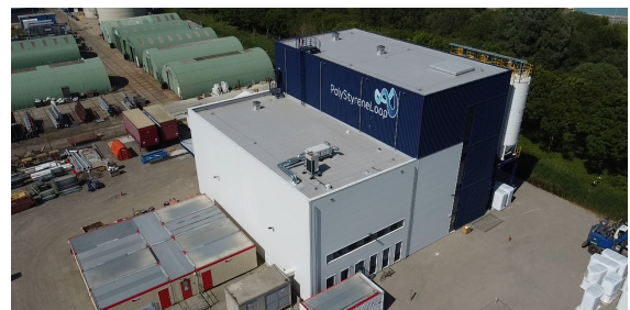
PS-Loop-Anlage im niederländischen Terneuzen, Foto: PS-Loop B.V.
