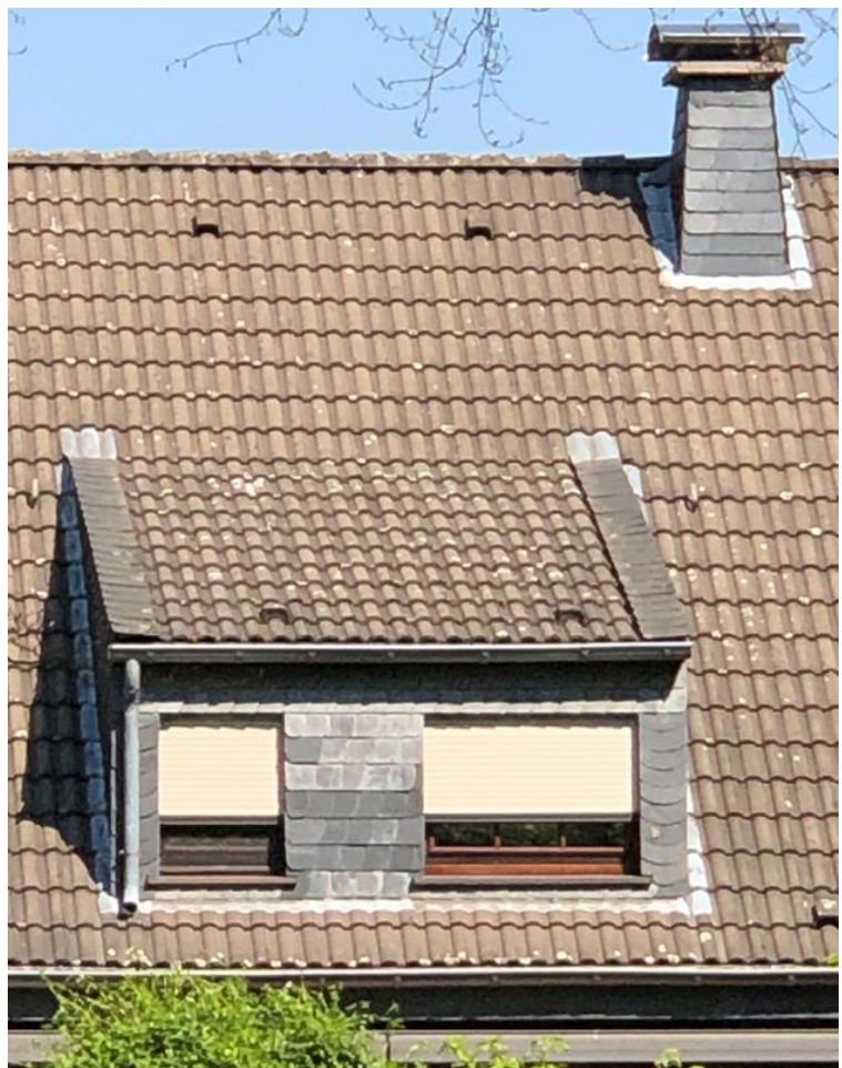
Bild 1 Anschlüsse aus Blei (hellgraues, patiniertes Material) rund um die Gaube und den Kamin
